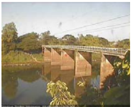
บ้านตาลปากน้ำ - อ.ท่าอุเทน จ.นครพนม (แม่น้ำสงคราม/ลุ่มน้ำโขงอีสาน)
