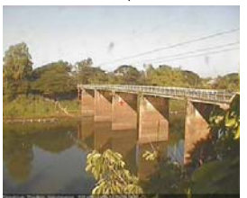
บ้านดงปากน้ำ - อ.ท่าอุเทน จ.นครพนม (แม่น้ำสงคราม/ลุ่มน้ำโขงอีสาน)
