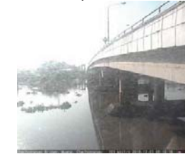
เขิงสะพานฉะเชิงเทรา - อ.เมือง จ.ฉะเชิงเทรา (ลุ่มน้ำบางปะกง)
