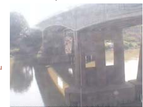
เชิงสะพานสิงห์บุรี - อ.เมือง จ.สิงห์บุรี (ลุ่มน้ำเจ้าพระยา)
