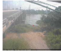
สะพานข้ามแม่น้ำท่าจีน ทางหลวง346 อ.บางเลน จ.นครปฐม (ลุ่มน้ำท่าจีน)
