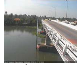
สะพานบุญรัตนประชาวัฒน์ - อ.สามพราน จ.นครปฐม (ลุ่มน้ำท่าจีน)
