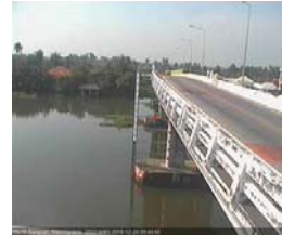
สะพานบุญรัตนประชาวินทร์ - อ.สามพราน จ.นครปฐม (ลุ่มน้ำท่าจีน)
