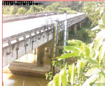
สถานีบ้านม่วงก้อง – อ.สะเดา จ.สงขลา (กรมชลประทาน)
