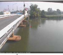
สะพานหลวงพ่อบึง - อ.นครไชยศรี จ.นครปฐม (ลุ่มน้ำท่าจีน)
