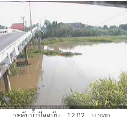
สะพานสามง่าม-ท่าโบสถ์ อ.หันคา จ.ชัยนาท (ลุ่มน้ำท่าจีน)
