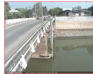
สถานีสะพานพระแม่ย่า อ.เมือง จ.สุโขทัย (ลุ่มน้ำยม)
