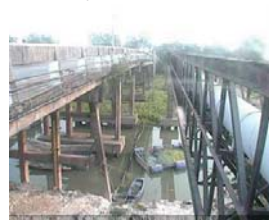
เชิงสะพานบริรักษ์ - อ.เมือง จ.อุทัยธานี (ลุ่มน้ำเจ้าพระยา)
