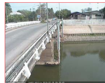
สถานีสะพานพระเมยา อ.เมือง จ.สุโขทัย (ลุ่มน้ำยม)
