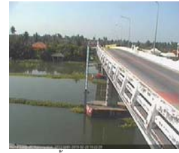
สะพานบุญรัตนประชาวันน - อ.สามพราน จ.นครปฐม (ลุ่มน้ำท่าจีน)
