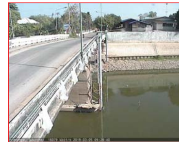
สถานีสะพานพระเมเยา อ.เมือง จ.สุโขทัย (ลุ่มน้ำยม)
