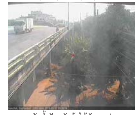
สะพานข้ามแม่น้ำท่าจีน ทางหลวง3365 อ.สามชุก จ.สุพรรณบุรี (ลุ่มน้ำท่าจีน)
