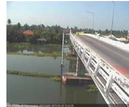
สะพานบุญรัตนประชาวินัย - อ.สามพราน จ.นครปฐม (ลุ่มน้ำท่าจีน)
