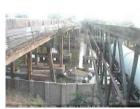
เชิงสะพานบริรักษ์ - อ.เมือง จ.อุทัยธานี (ลุ่มน้ำเจ้าพระยา)
