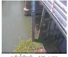
สะพานวัดพระรูป อ.เมือง จ.สุพรรณบุรี (ลุ่มน้ำท่าจีน)
