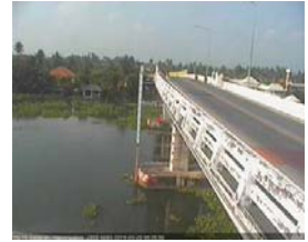
สะพานบุญรัตนประชานุกิตน์ - อ.สามพราน จ.นครปฐม (ลุ่มน้ำท่าจีน)
