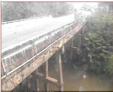
สถานีคลองตะหมัด(ท่าเขียด) - ต.แม่ขีรี อ.ตะโหมด จ.พัทลุง (ลุ่มน้ำทะเลสาบสงขลา)
