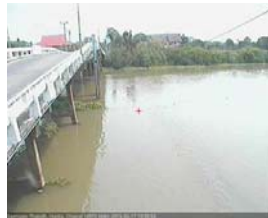
สะพานสามง่าม-ท่าโบสถ์ อ.หันคา จ.ชัยนาท (ลุ่มน้ำท่าจีน)
