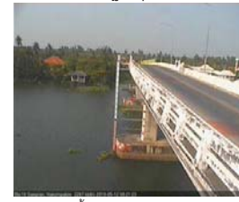
สะพานบุญรัตนประชาวัน - อ.สามพราน จ.นครปฐม (ลุ่มน้ำท่าจีน)
