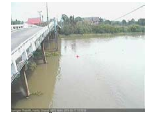
สะพานสามง่าม-ท่าโบสถ์ อ.หันคา จ.ชัยนาท (ลุ่มน้ำท่าจีน)
