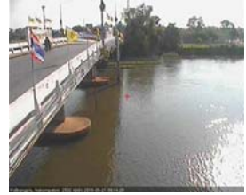
สะพานหลวงพ่อบึง - อ.นครไชยศรี จ.นครปฐม (ลุ่มน้ำท่าจีน)
