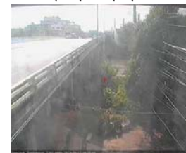
สะพานข้ามแม่น้ำท่าจีน ทางหลวง365 อ.สามชุก จ.สุพรรณบุรี (ลุ่มน้ำท่าจีน)
