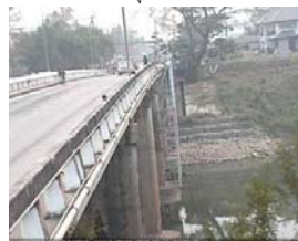
สะพานศรีรัตนาลัย - อ.ศรีรัตนาลัย จ.สุโขทัย (ลุ่มน้ำยม)
