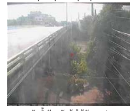
สะพานข้ามแม่น้ำท่าจีน ทางหลวง365 อ.สามชุก จ.สุพรรณบุรี (ลุ่มน้ำท่าจีน)
