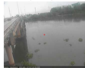
สะพานข้ามแม่น้ำท่าจีน 3 - อ.เมือง จ.สมุทรสาคร (ลุ่มน้ำท่าจีน)
