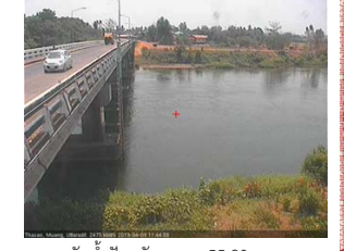
สะพานท่าเสา - อ.เมือง จ.อุตรดิตถ์ (ลุ่มน้ำน่าน)
