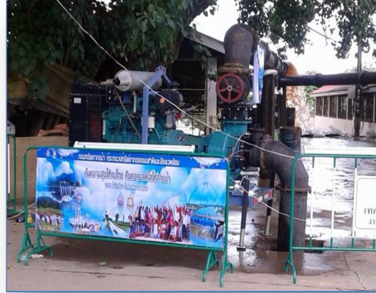
เครื่องสูบน้ำ ขนาด ๑๒ นิ้ว อัตราการสูบ ๐.๔๕ ลบ.ม/วินาที
