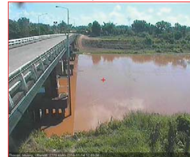
สถานีสะพานท่าเสา อ.เมือง จ.อุดรดิตถ์ (ลุ่มน่าน)
