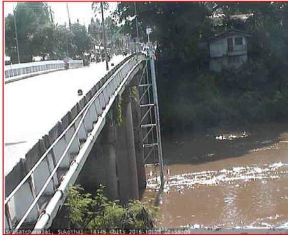
สถานีสะพานศรีราชนาลัย อ.ศรีราชนาลัย จ.สุโขทัย (ลุ่มน้ำยม)
