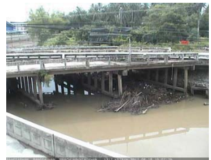
ร.ร.อนุบาลบางสะพาน - อ.บางสะพาน จ.ประจวบคีรีขันธ์ (คลองบางสะพาน/ชายฝั่งทะเลตะวันตก)
