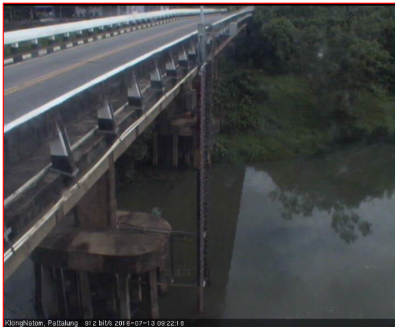
สถานีคลองนาท่อม - ต.ร่มเมือง อ.เมือง จ.พัทลุง (ลุ่มน้ำทะเลสาบสงขลา)
