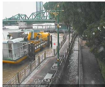
สะพานพุทธ - เขตธนบุรี จ.กรุงเทพฯ (ลุ่มน้ำเจ้าพระยา)
