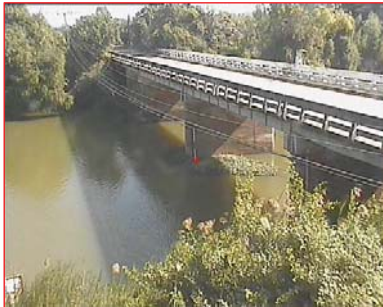
สถานีบ้านเหล่านกชุม ต.คอนหัน อ.เมือง จ.ขอนแก่น(ลุ่มน้ำชี)
