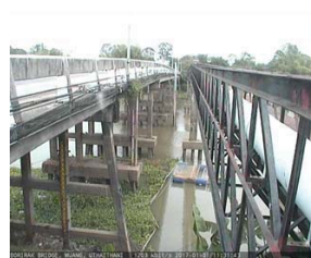
เขิงสะพานบริรักษ์ - อ.เมือง จ.อุทัยธานี (ลุ่มน้ำสะแกกรัง)
