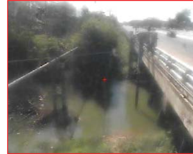
สถานีห้วยหลวง ต.หมอน อ.เมือง จ.อุดรธานี(ลุ่มน้ำโขง)
