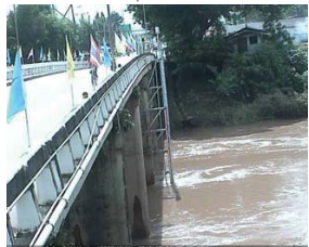
สะพานศรีษะนาถาย - อ.ศรีษะนาถาย จ.สุโขทัย (ลุ่มน้ำยม)
