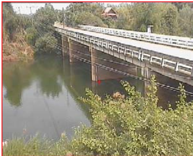
สถานีบ้านเหล่ากชุมต.คอนหัน อ.เมือง จ.ขอนแก่น(ลุ่มน้ำชี)
