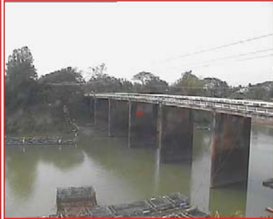
สถานีบ้านตลปักษ์น้ำ ต.ไชยบุรี อ.ท่าอุเทน จ.นครพนม (ลุ่มน้ำโขง)
