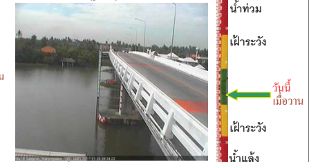
สะพานบุญรัตนประชาคุณวัฒน์ - อ.สามพราน จ.นครปฐม (คู่น้ำท่าจีน)
