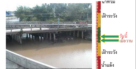
ร.ร.อนุบาลบางสะพาน - อ.บางสะพาน จ.ประจวบคีรีขันธ์ (คลองบางสะพาน/ชายฝั่งทะเลตะวันตก)
