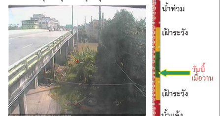
สะพานข้ามแม่น้ำท่าจีน ทางหลวง3365 อ.สามชุก จ.สุพรรณบุรี (คู่น้ำท่าจีน)
