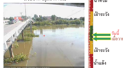
สะพานสามงาม-ท่าโบสถ์ อ.หันคา จ.ชัยนาท (คู่น้ำท่าจีน)
