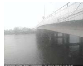
เขื่อนสะพานฉะเชิงเทรา - อ.เมือง จ.ฉะเชิงเทรา (ลุ่มน้ำบางปะกง)
