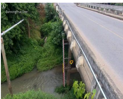
สะพานบ้านหนองปรือ - อ.หนองปรือ จ.กาญจนบุรี (ลุ่มน้ำแม่กลอง)
